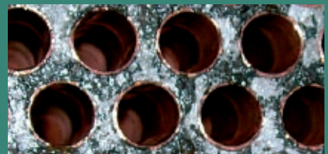
Temizleme sonrası boru
