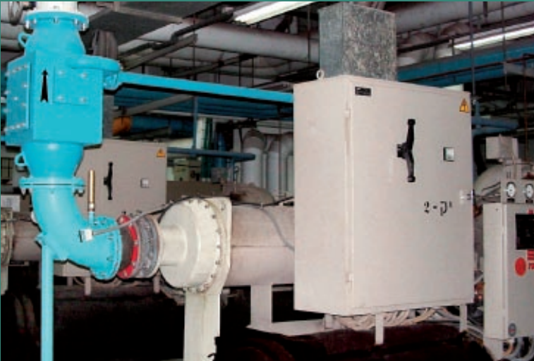
Trane CVGD chiller üzerinde kurulu Boru Temizleme sistemi
