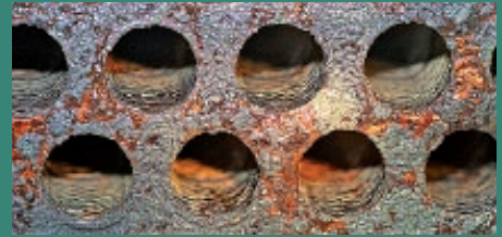
Temizleme öncesi boru
